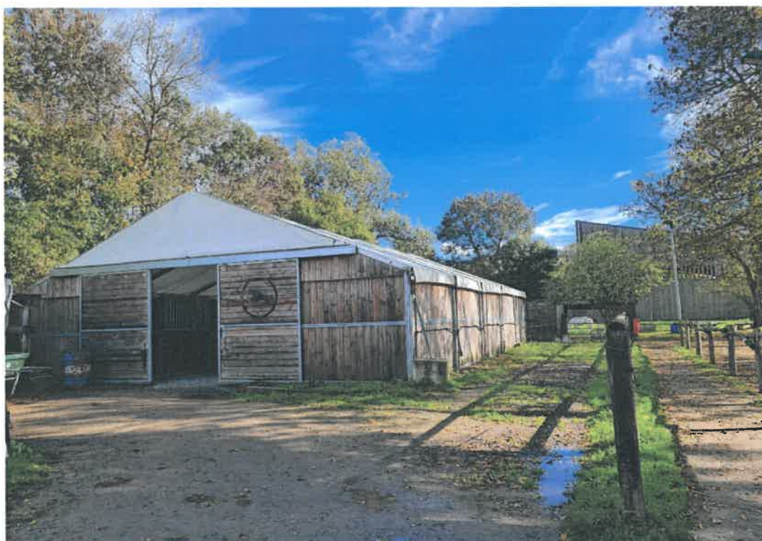
LE BARN CACHE DERRIÈRE LES ARBRES ET LES HAIES QUI N'ONT PAS ÉTÉ MODIFIÉS. SE FOND PARFAITEMENT DANS LE PAYSAGE DEVANT LE MANÈGE LUI AUSSI EN BOIS
