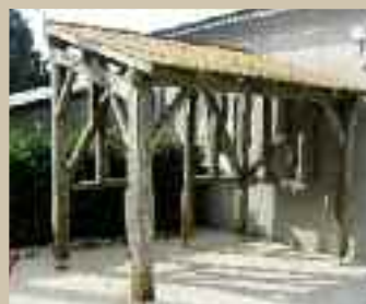
16 H 30. Ouf terminé ! Posé le long de la façade sud, l'abri sera à nouveau couvert de ses tuiles. Les jeunes pourront ainsi profiter au maximum de la terrasse..
